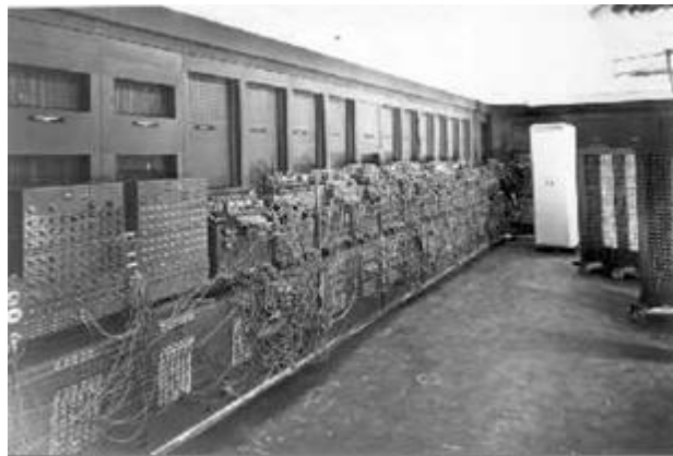
Vista parcial del ENIAC. La máquina contenía 18.000 tubos al vacío y 1500 relés.
